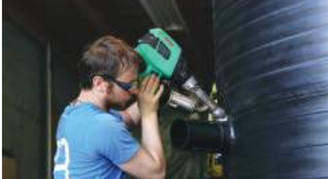
Удобный WELDPLAST S2 в работе
