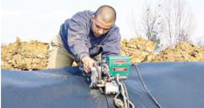
... на обустройстве полигона
