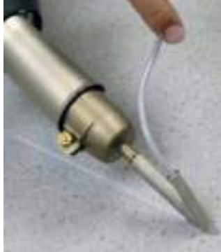
Сварка напольных покрытий ручным аппаратом TRIAC ST
