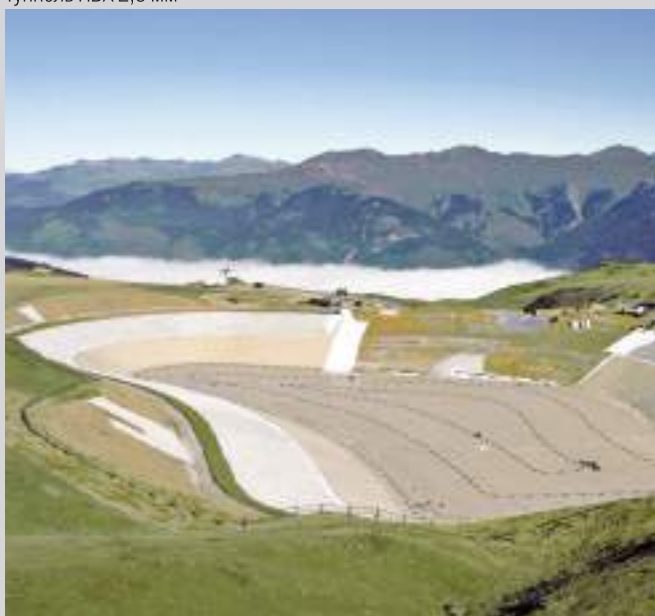
Водохранилище ПВД 2,0 мм
