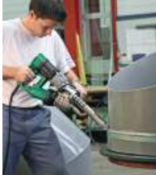
Экструдер FUSION 3C при сварке резервуара
